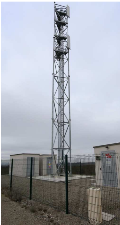
Obrázek 14: Základnová BTS GSM-R včetně stožáru na LGV Est.
