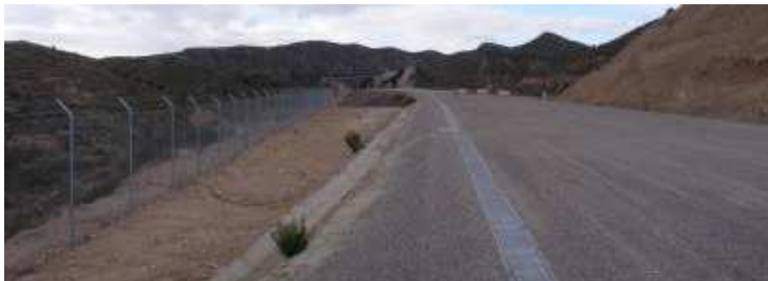
Obrázek 11: Kabelová trasa z betonových žlabů (ES)
