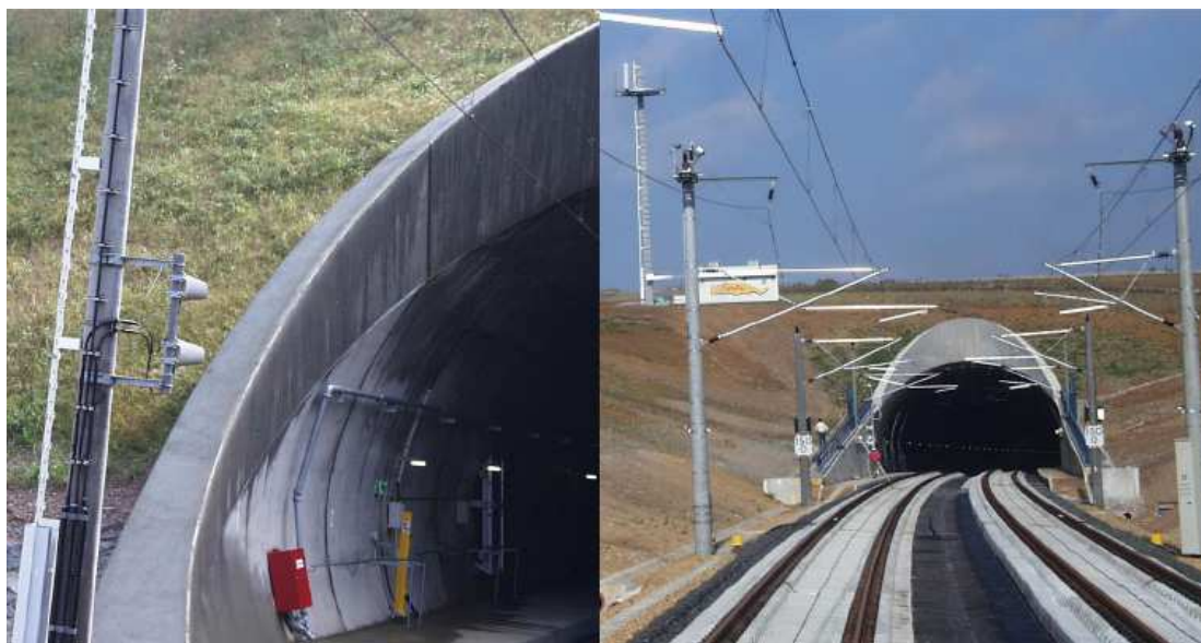
Obrázek 15: Pokrytí tunelu rádiovým signálem v Německu (VRT Frankfurt – Köln)
